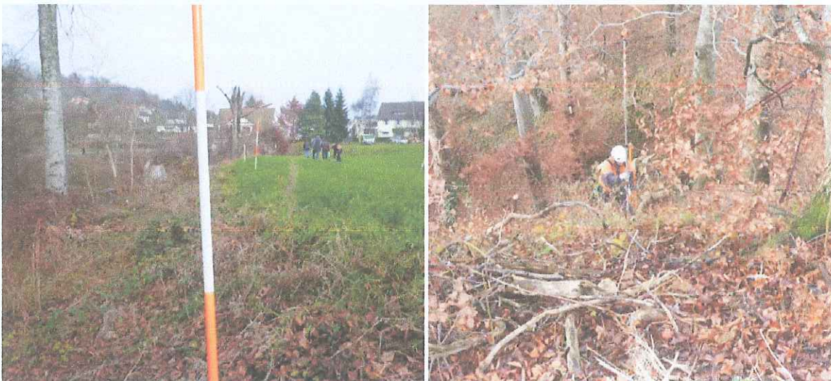
Abb.8: links die Flurstücksgrenze an der Hangkante, rechts: Einmessen des Schutzstreifens
