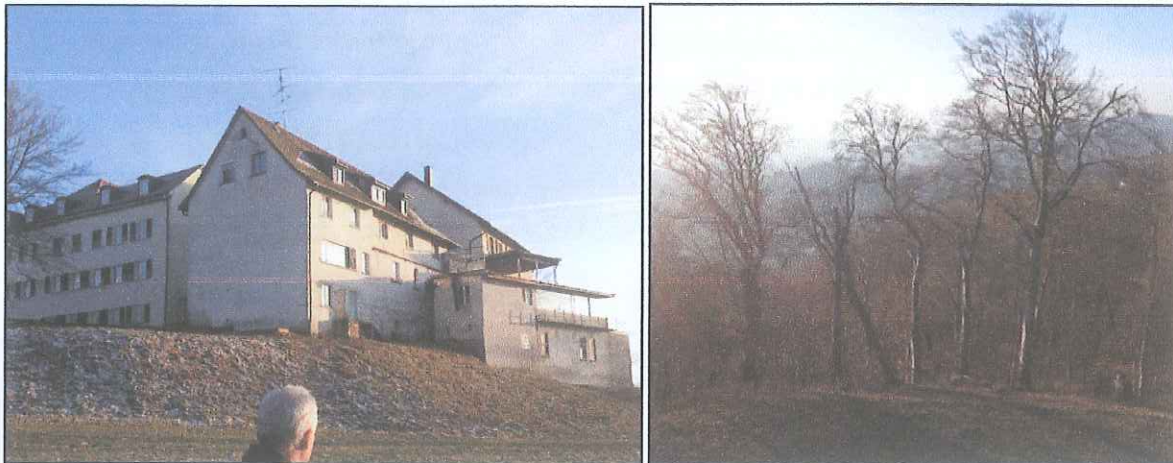
Abb. 15: Die Fassade des ehem. Hotels „Post“ innerhalb des LSG und die Traufbuchen
